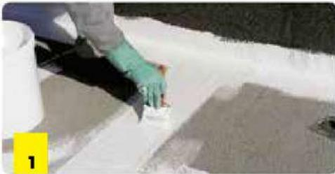
Tratar específicamente los puntos críticos como: desagües, ventilaciones, encuentros de planos, babetas, juntas de dilatación, etc. En estos puntos singulares, es recomendable utilizar una venda geotextil como refuerzo entre la primera y la segunda mano.
